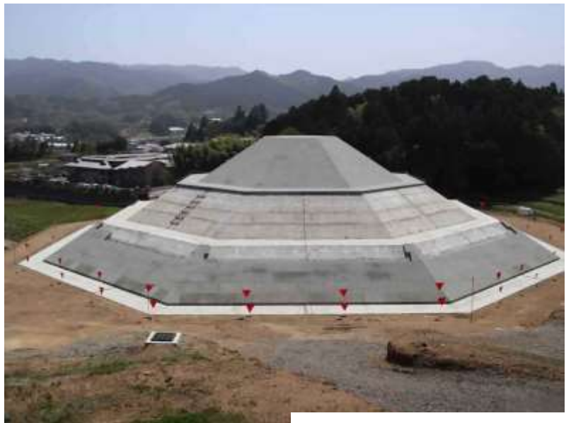
造成工事中の牽牛子塚古墳
